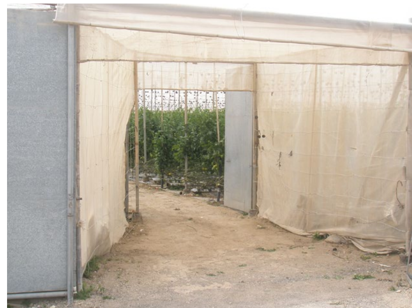
Foto 3. Doble puerta de entrada a invernadero.
